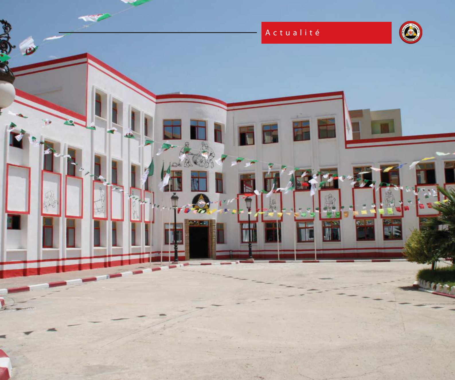
L'unité de secteur de Bouderbala, une infrastructure qui vient à point...
